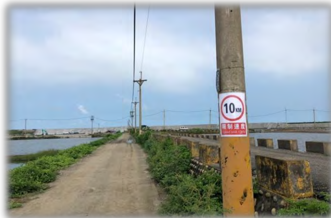
工區進出使用既有道路 並限制車輛行進速度
