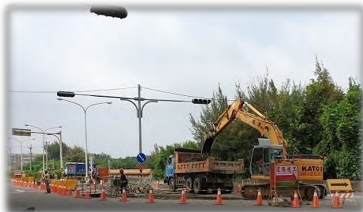
運土車停放於挖土機旁
