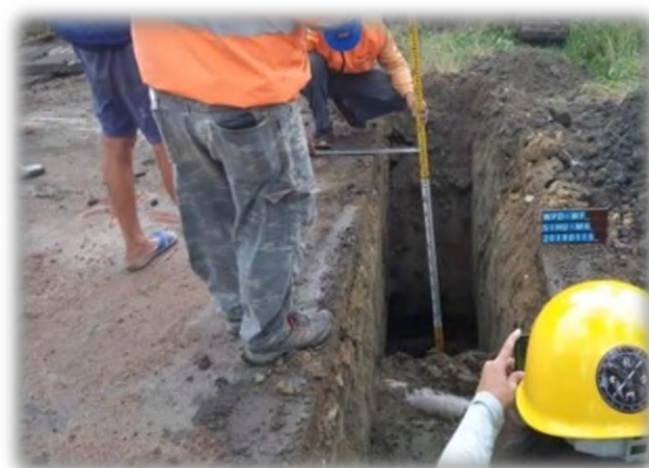
開挖期間施工監看
