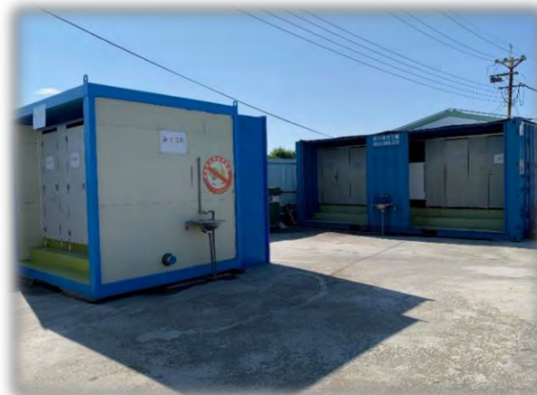
設置流動廁所並 委託合格代清除處理業處理
