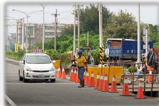
分段施工並派員疏導交通
