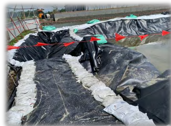
設置HDD擴管出土收集坑
