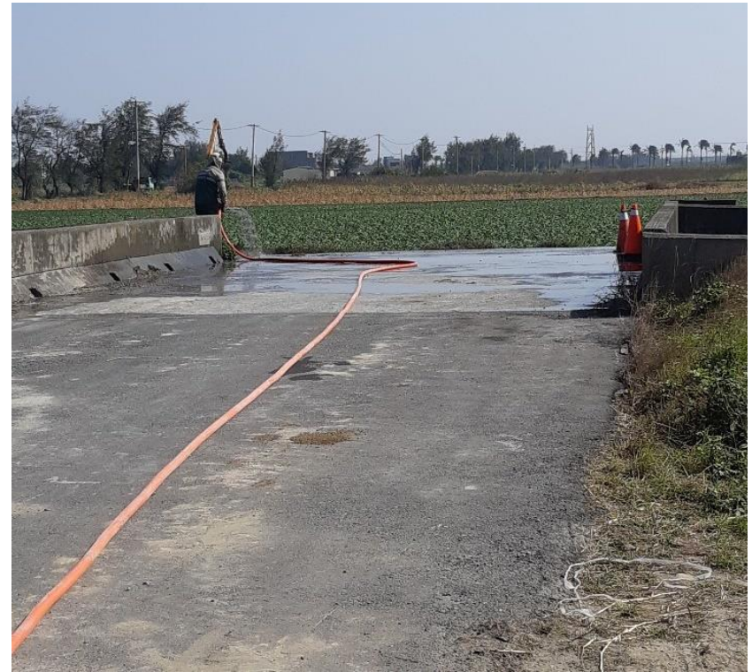
工區周邊道路維護清掃
